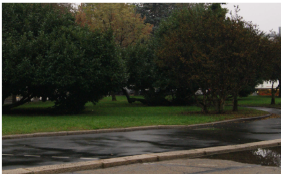
Marciapiede e strade: stato di conservazione e sistemi di scolo
