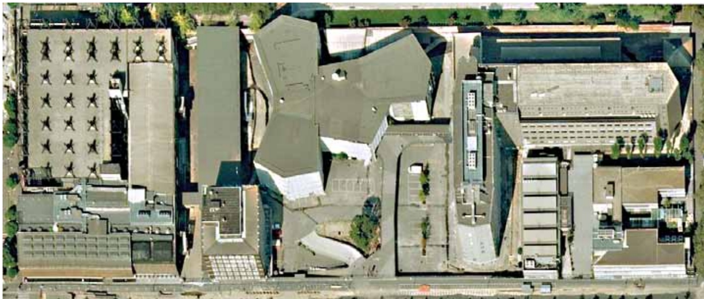
Figura 1 - Veduta aerea del Campus Bonardi, Politecnico di Milano.
